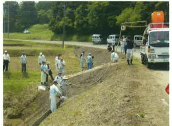
<6月7日 杵築市年田 吹きつけ状況>
