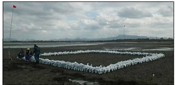
図3 土のう囲い試験区の作成
