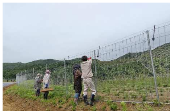
柵設置作業（豊後大野市）
