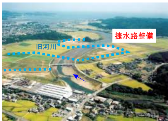
八坂川(整備済区間)
