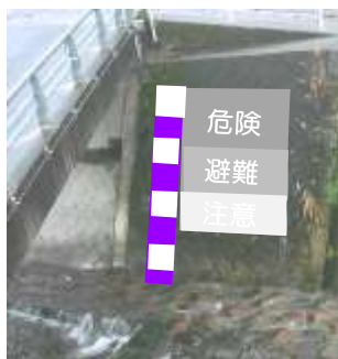
[設置後(通常時)]
