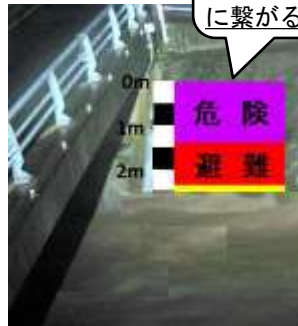
[設置後(増水時)]
