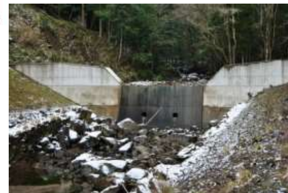
土砂を捕捉した治山ダム
