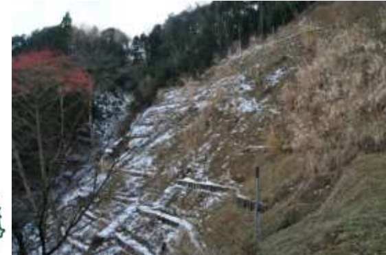
土砂を捕捉した治山ダム
