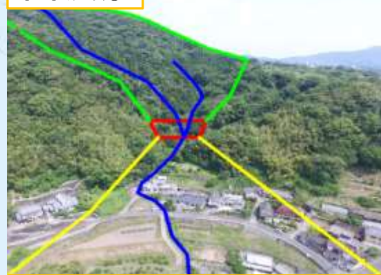
砂防設備の整備
