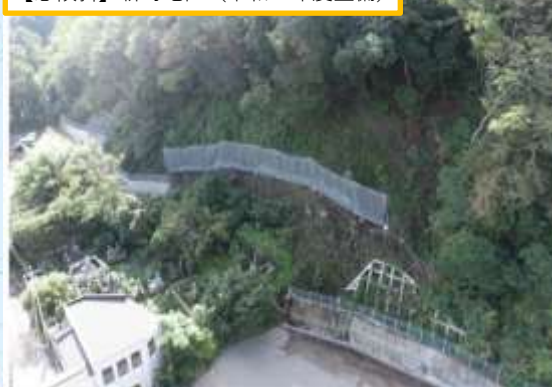
急傾斜地崩壊対策施設の整備
