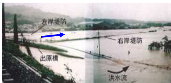
八坂川浸水写真(H9年9月)
