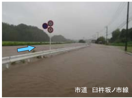
熊崎川浸水写真(H23年9月)
