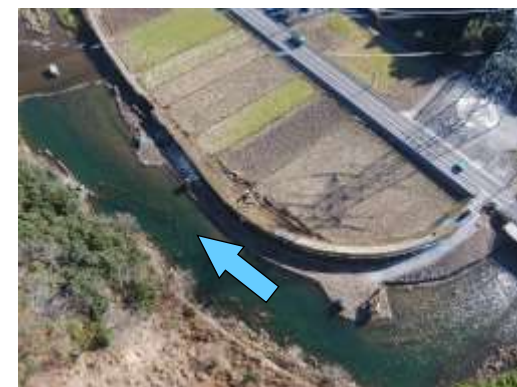
臼杵川(整備中區間)
