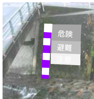
[設置後(通常時)]
