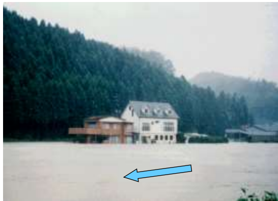
臼杵川浸水写真(H9年9月)
