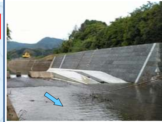
熊崎川(整備中写真)
