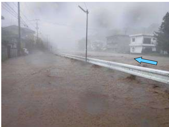
津久見川浸水写真(H29年9月)
