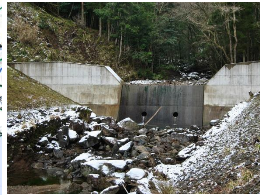
土砂を捕捉した治山ダム
