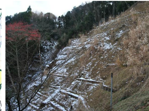
土砂を捕捉した治山ダム
