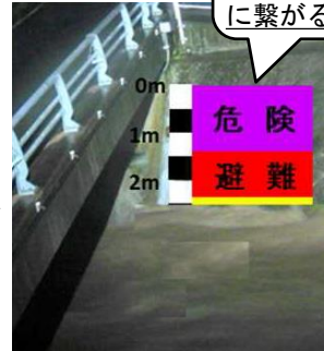
[設置後(増水時)]
