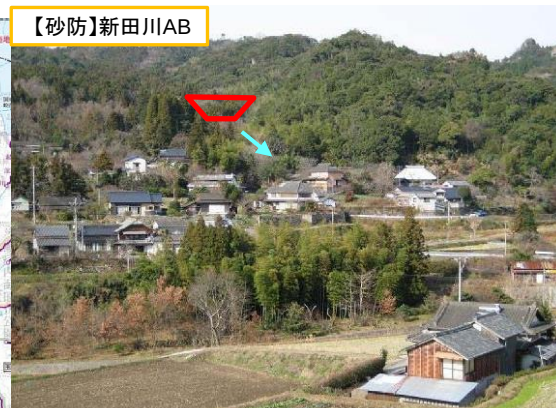
砂防設備の整備
