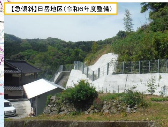
急傾斜地崩壊対策施設の整備
