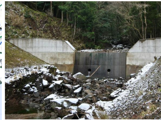
土砂を捕捉した治山ダム
