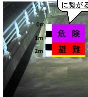
〔設置後（増水時）〕
