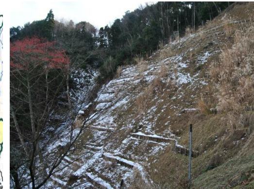
土砂を捕捉した治山ダム
