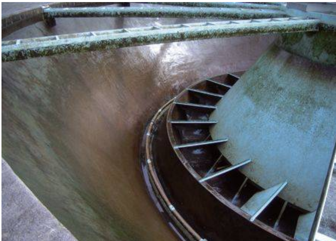
沈殿池清掃作業中
