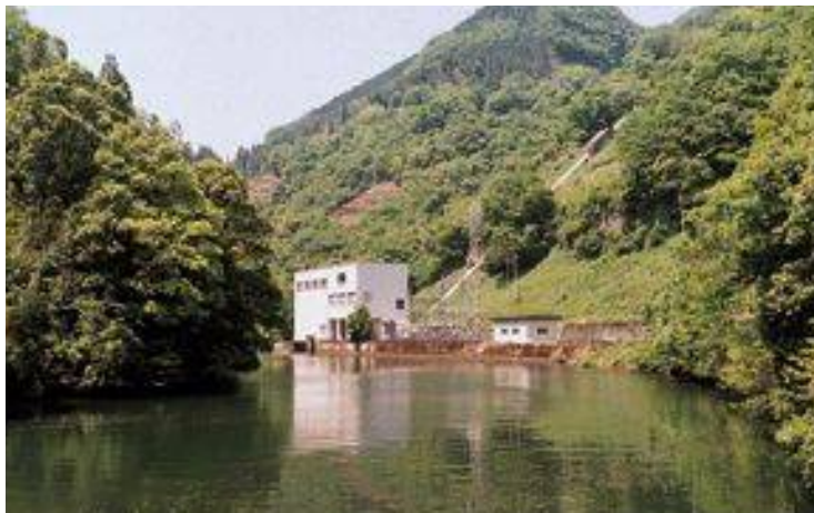
芹川第一発電所
