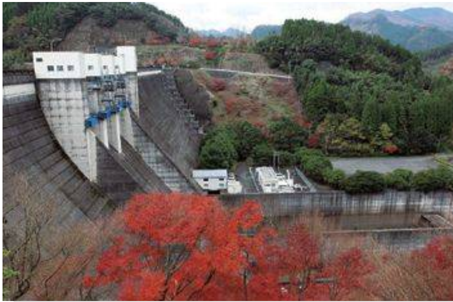
耶馬溪発電所
