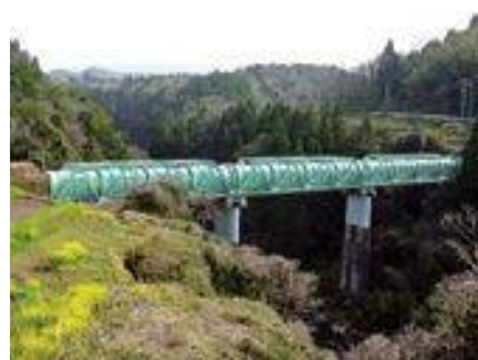
三重川水管橋
