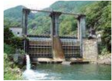
逆調整池ダム
