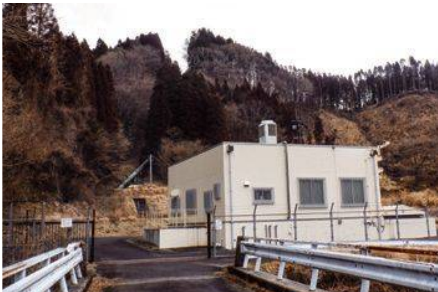
鳴子川発電所
