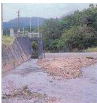
白水川取水堰
