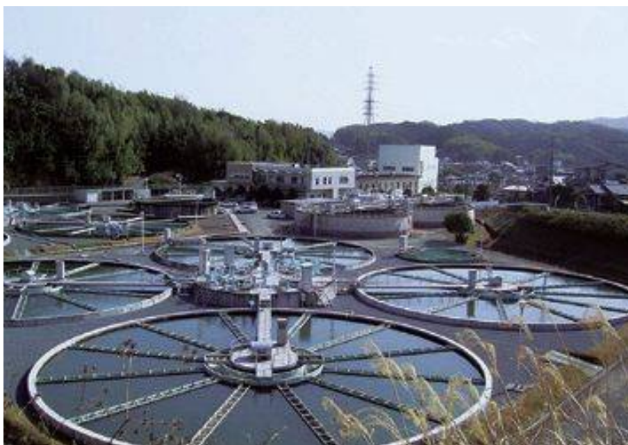
判田浄水場（大分市）
