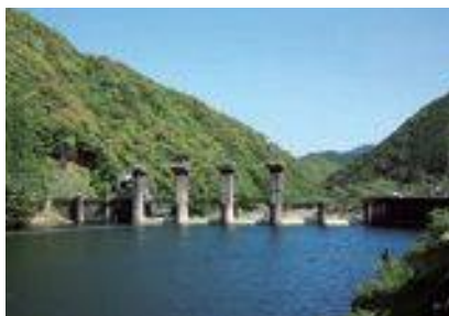
下赤逆調整池ダム
