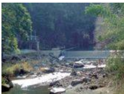
三重川取水堰
