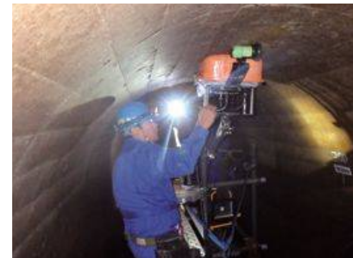
送水隧道点検中(火振志村線)
