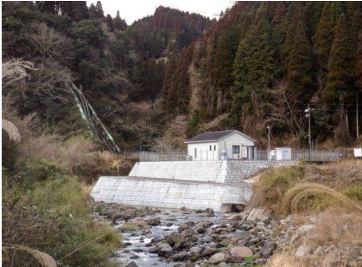
阿蘇野川発電所
