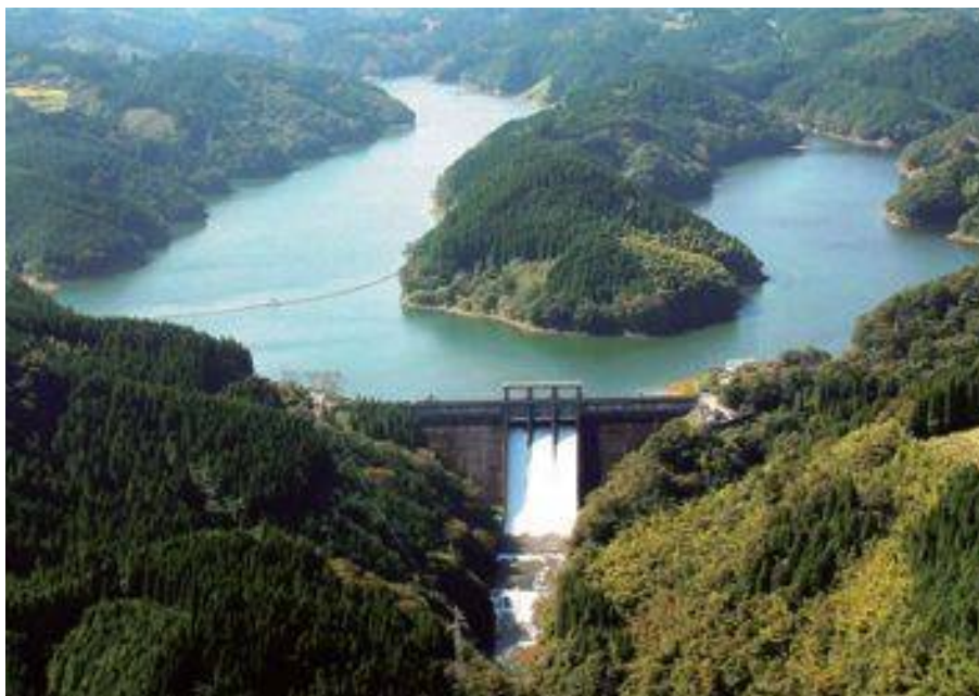
芹川ダム（左岸：竹田市、右岸：大分市）
