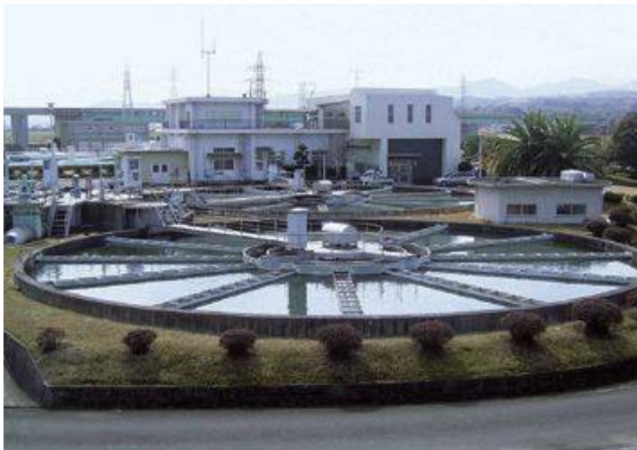
大津留浄水場（大分市）
