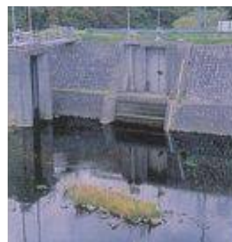
鳴子川取水堰
