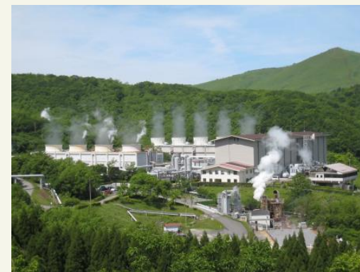
八丁原発電所（地熱）
