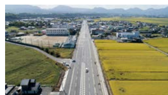
地域間交流を促進する道路の整備
