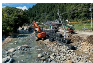
被災直後に応急対応する 建設業者
