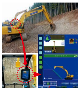
ICT 建設機械を活用した工事
