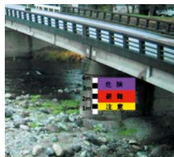
防災情報の充実・強化（量水標設置）
