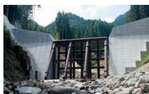
砂防えん堤の整備
