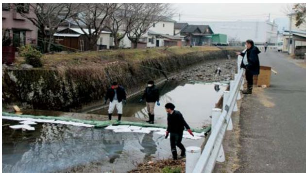
職員による迅速な対応 (河川に流出した油の処理)
