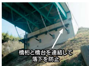
橋梁の耐震補強（落下に対する安全性確保）
