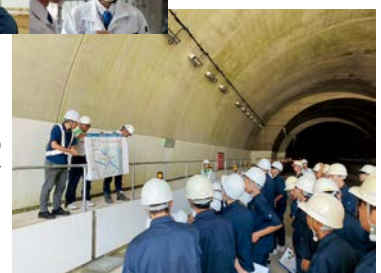
高校生向けの トンネル現場見学会
