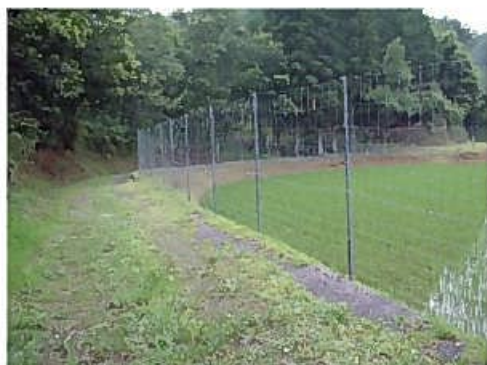
侵入防止柵の設置
