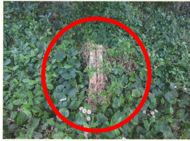
・ 標柱が腐れて倒れている
