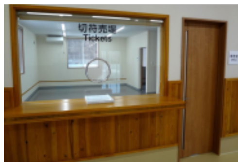
CLT により整備した受付カウンター
