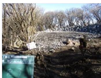
大船山避難小屋撤去
