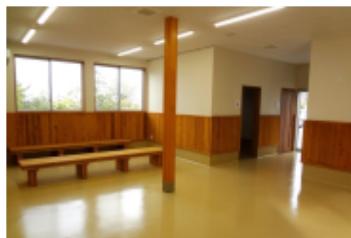
CLT により整備した待合室
