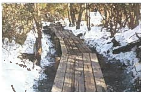
九州自然歩道木道整備
