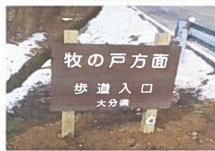
九州自然歩道標識改修
