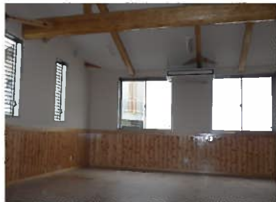
【内部：腰壁・造作材（杉材）】
