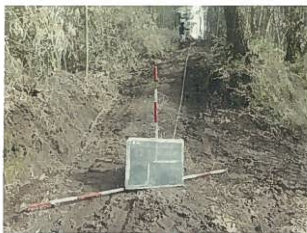
【簡易作業路の開設状況】
