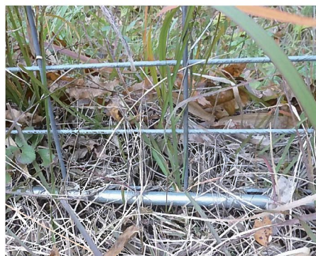
柵下をパイプで補強
