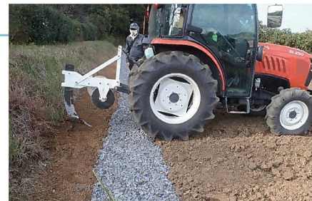
深く弾丸暗きよを通すため法面側にスペースを設ける
