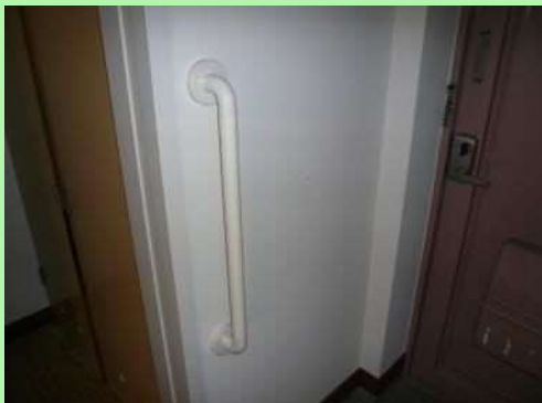
手すりの設置
