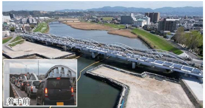
国道197号(鶴崎拡幅) 進捗状況
