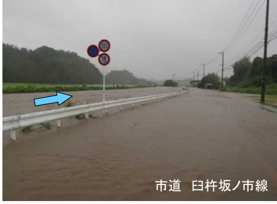
熊崎川浸水写真(H23年9月)
