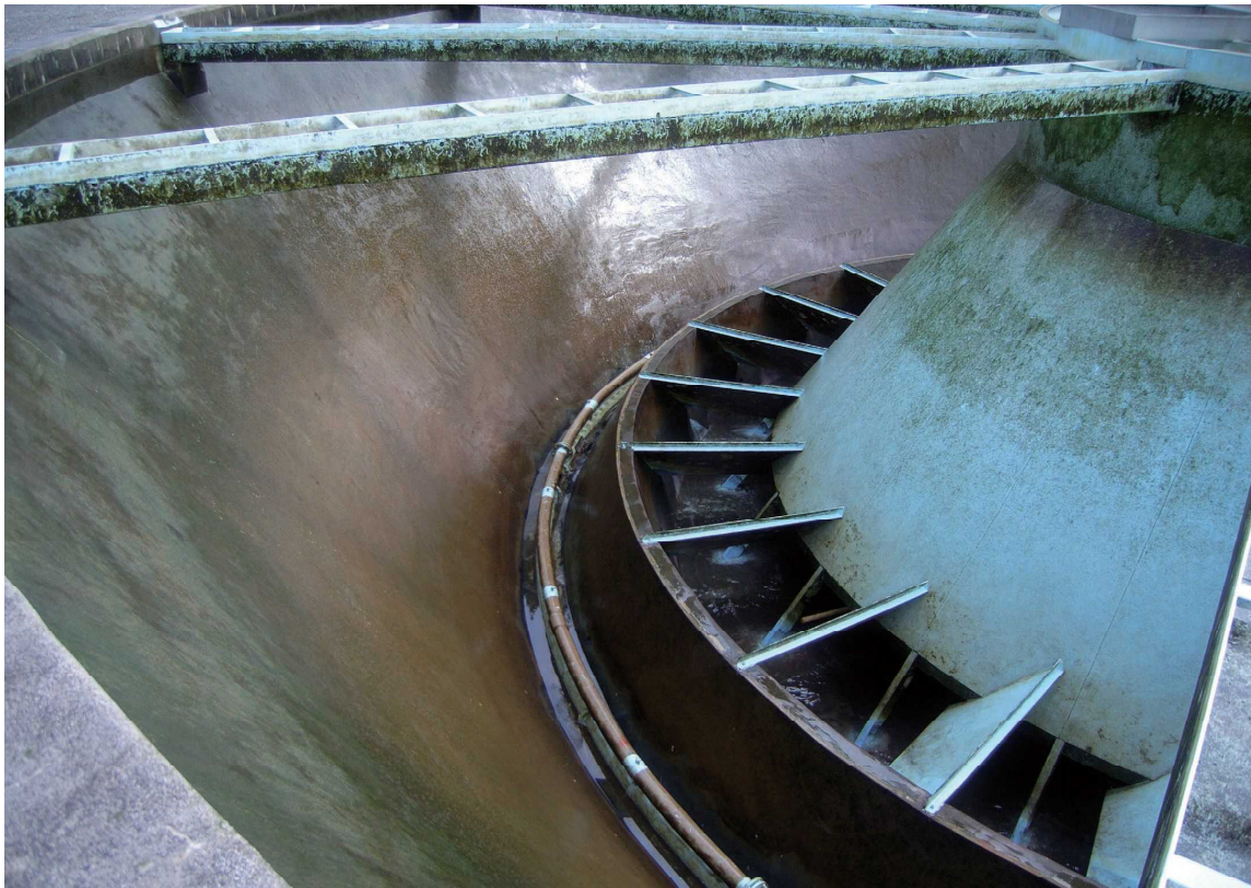
沈澱池清掃作業中
