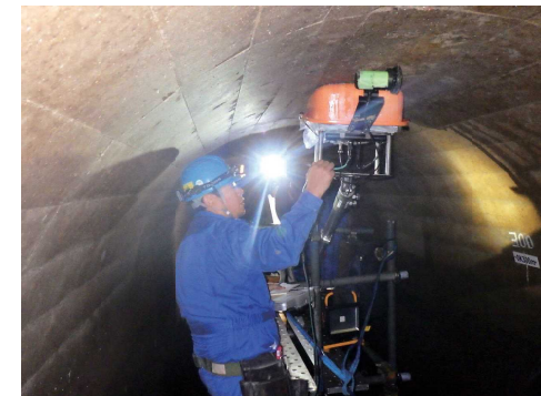
送水隧道点検中(火振志村線)
