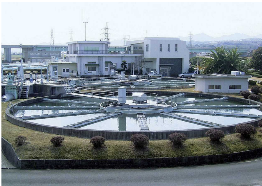
大津留浄水場（大分市）
