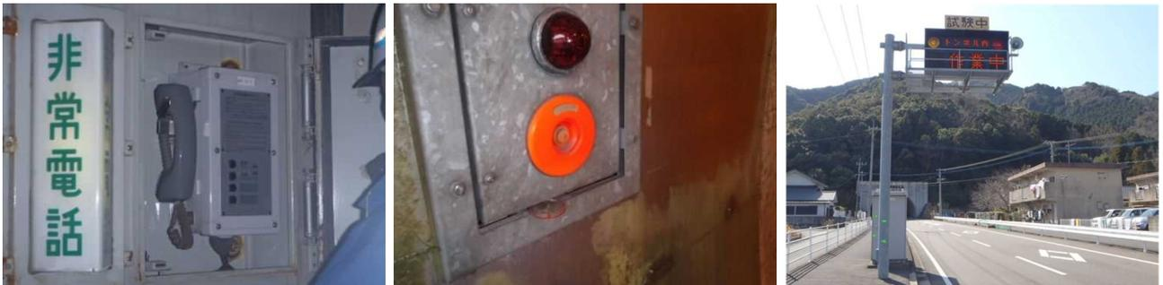
図 2-2 非常電話、押しボタン式通報装置、警報表示板
