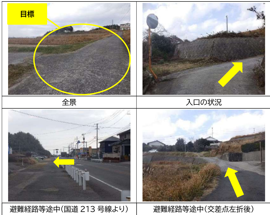
写真3 避難施設等の状況
