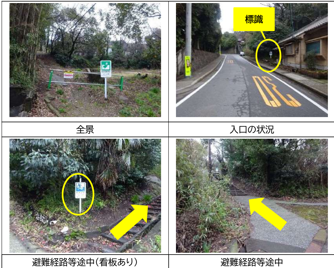
写真1 避難施設等の状況
