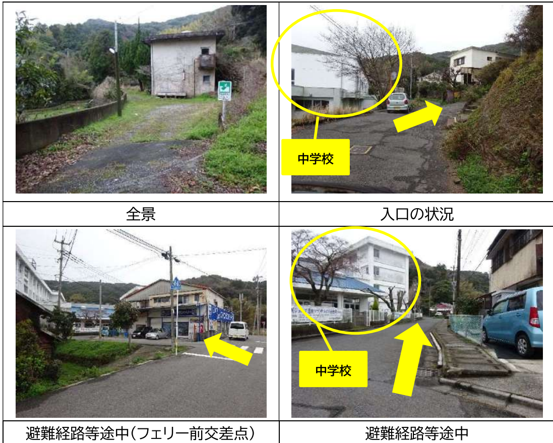
写真 1 避難施設等の状況
