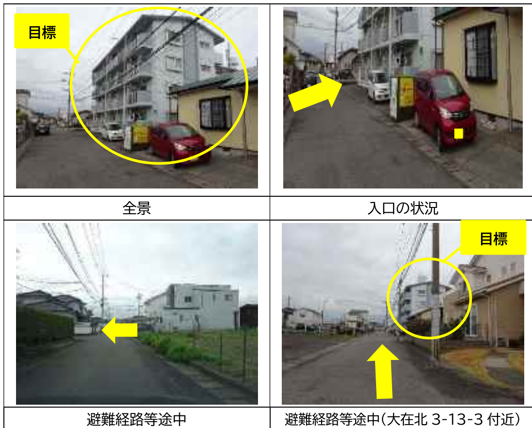
写真 5 避難施設等の状況
