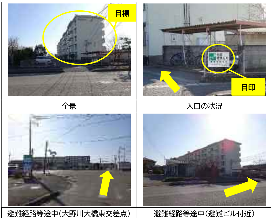
写真 2 避難施設等の状況
