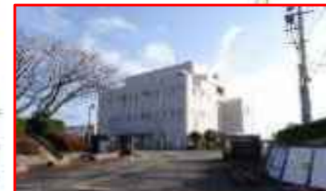
434 弁天水資源再生センター
