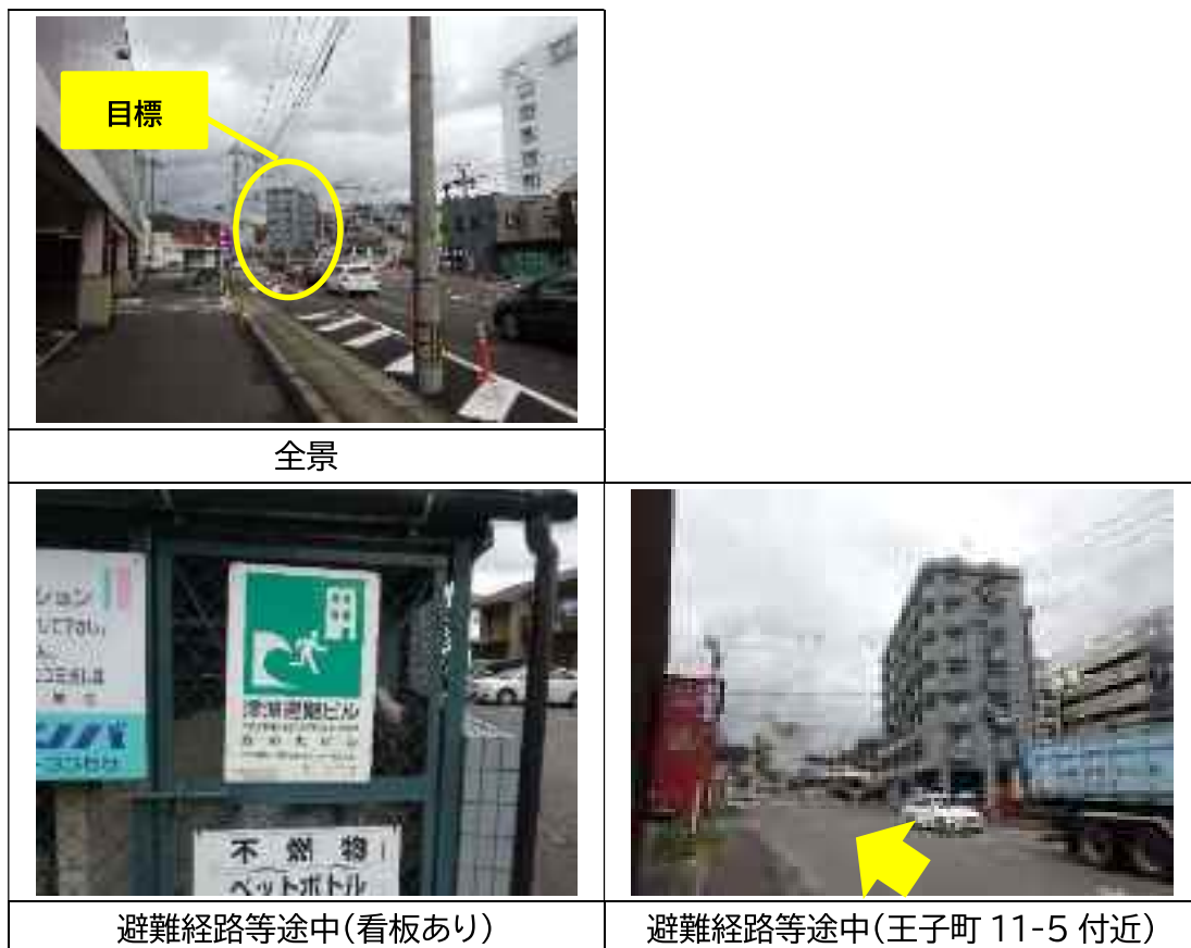
写真 1 避難施設等の状況
