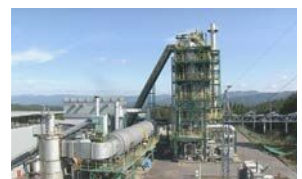
木質バイオマス発電所 (日田市)
