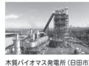
木質バイオマス発電所(日田市)
