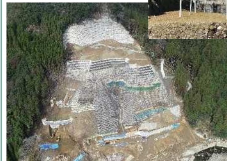
←山腹工と 地すべり防止工事
