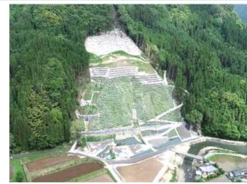
災害復旧工事
