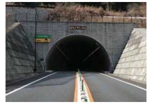
道路トンネル数 576 本 (H30.4.1)
