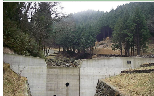
谷が削られないようにしたり土石が流れ出ないようにする谷止工
