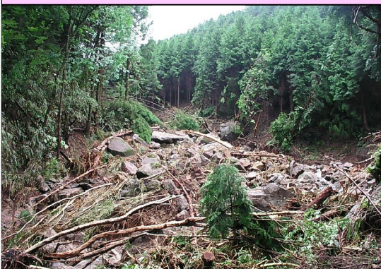
土石流などで荒廃している溪流
