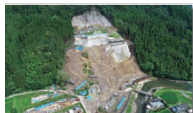
山腹崩壊からの復旧が進む耶馬溪町金吉地区
