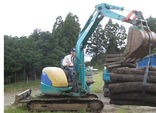
小型バックホーは狭小地で活用
