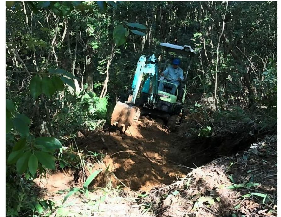
作業道開設（バックホー）
