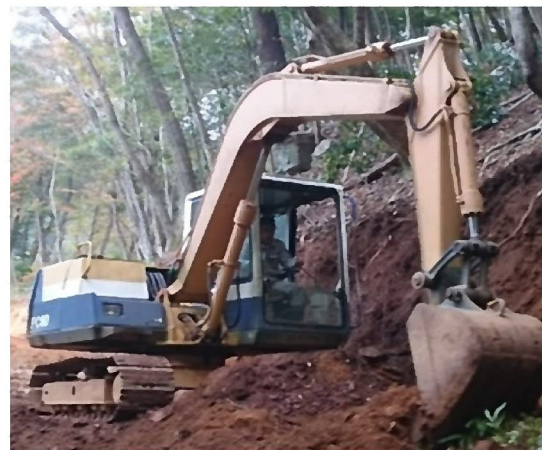
作業路開設（バックホー）
