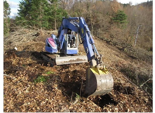
作業道開設（バックホー）
