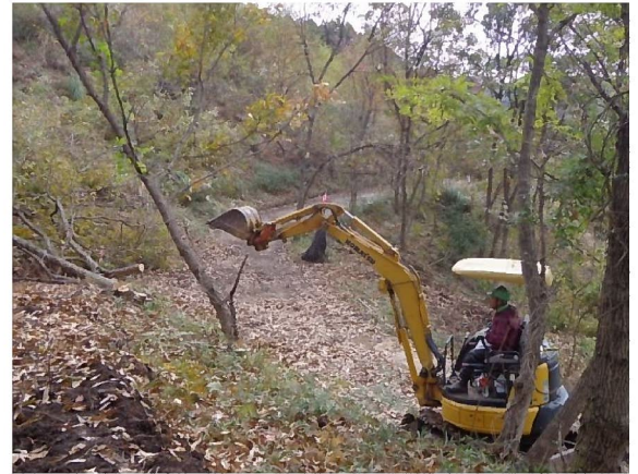
伐倒方向調整（バックホウ）
