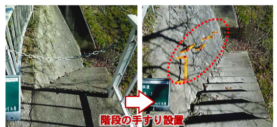
作業場所へのアクセス改善による作業軽減
