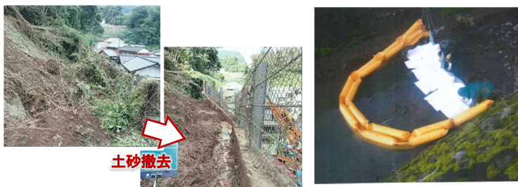
急傾斜施設の堆積土砂撤去やオイルマット設置状況
