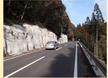
国道442号 合瀬工区（日田市）
