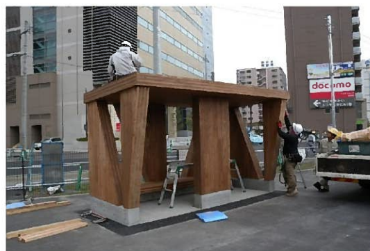
CLT実証棟施工見学会
