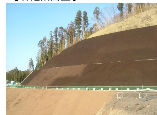
稲葉ダム右岸下流の3号林道法面吹付け完了。
