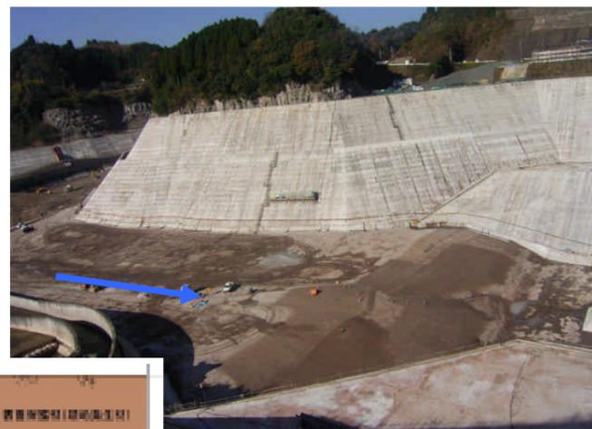
アスファルトフェーシング工(1工区)のアスファルトと岩盤の間の緩衝材であるトランジション(碎石)の工事が始まりました。碎石は、1日に約60台のダンプトラックで大分から運んでいます。
