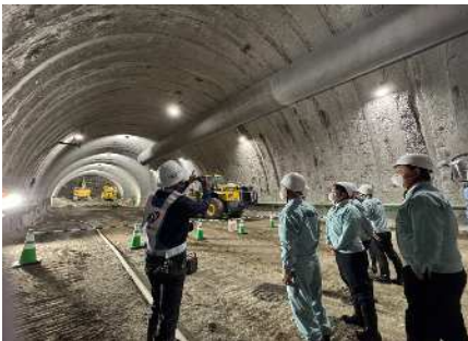
国道212号(日田山国道路) 道路改良事業
