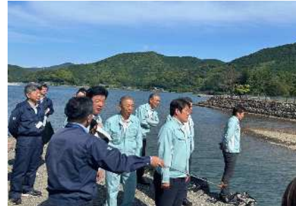
国道388号（畑野浦一楠本バイパス） 道路改良事業
