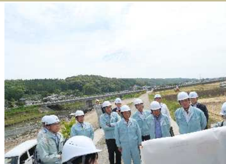
安岐川 河川災害復旧工事
