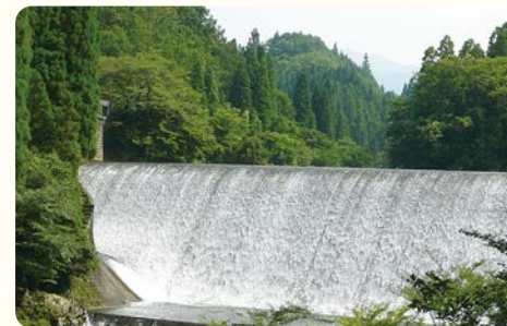
⑬ 白水溜池堰堤水利施設一溝 / 竹田市
