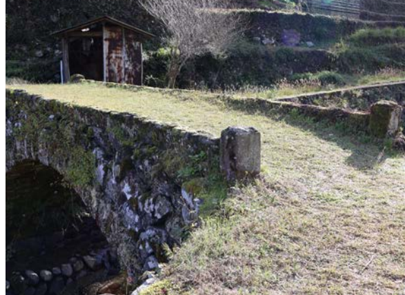
路面が芝に覆われた両合川橋
