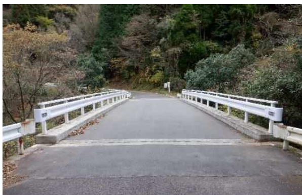
林道橋（御座ヶ岳線塚野山橋）
