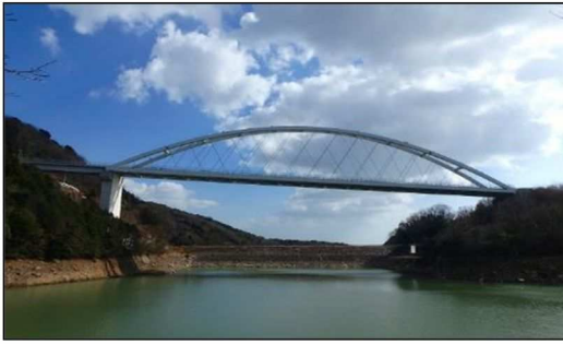
橋梁(石山天空橋)
