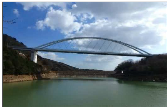
鋼橋（石山天空橋）
