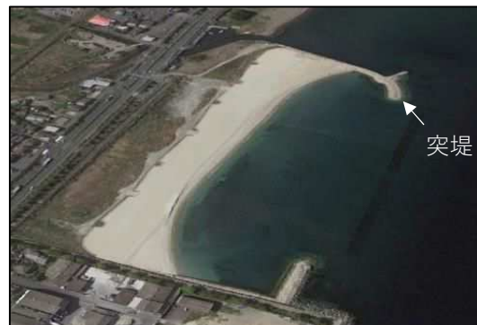
突堤（別府港海岸(関の江地区)）
