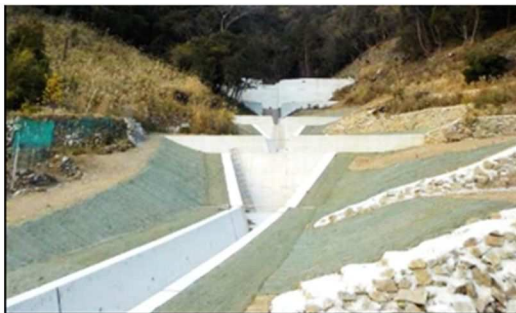
治山施設(小浦地区)
