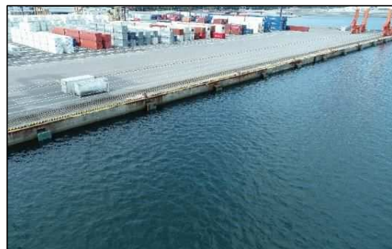
係留施設[岸壁]（大分港（大在地区））
