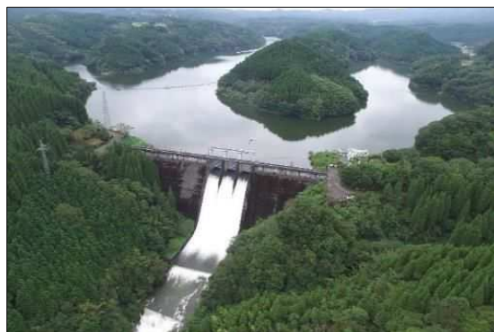
ダム（芹川ダム）
