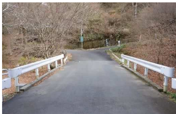
林道橋（御座ヶ岳支線1号橋）
