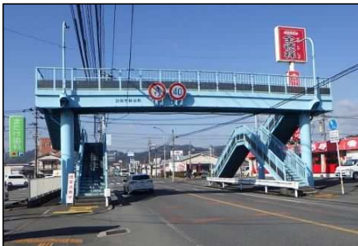
横断歩道橋（新治横断歩道橋）
