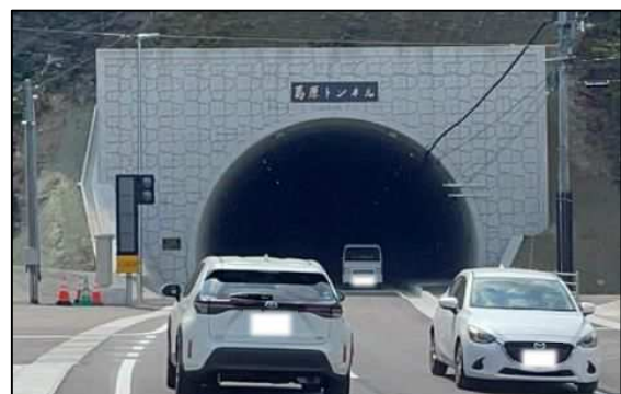
葛原トンネル
