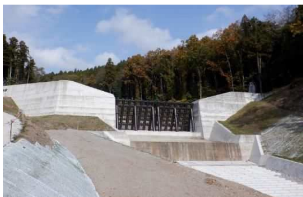
砂防設備（朝日川砂防堰堤）
