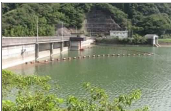
コンクリートダム(香下ダム)
