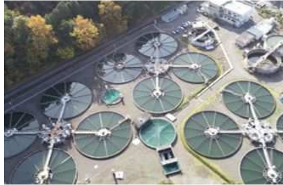
浄水場（判田浄水場）
