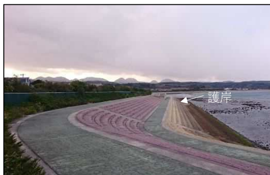
護岸（国東港海岸(富来地区)）
