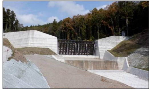
砂防施設(朝日川砂防堰堤)
