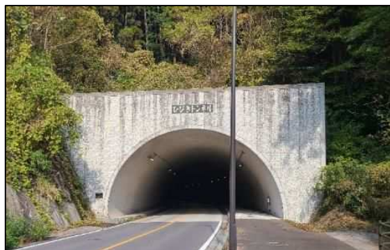
ひびきトンネル
