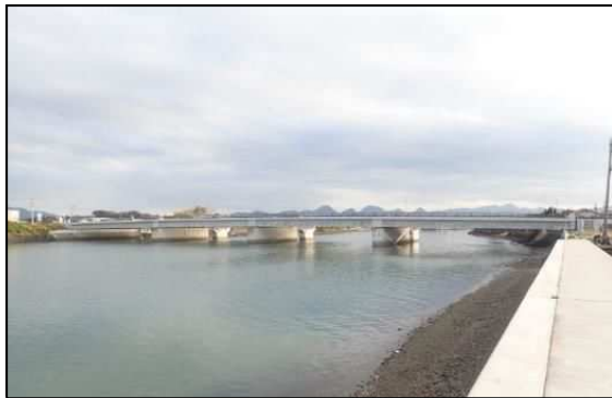
コンクリート橋（新今津大橋）
