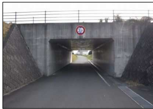
大型カルバート（三重新殿線）
