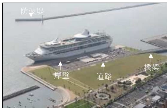
外郭施設[防波堤]等（別府港(石垣地区)）
