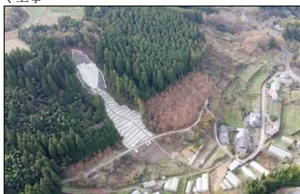
山腹工(木六地区)
