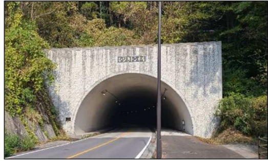
トンネル(ひびきトンネル)
