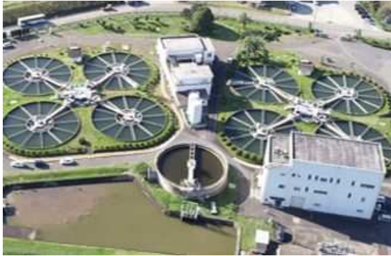
浄水場（大津留浄水場）
