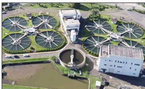
浄水場（大津留浄水場）
