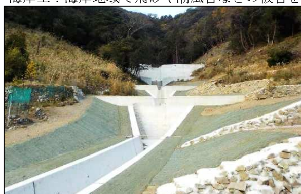
溪間工(小浦地区)
