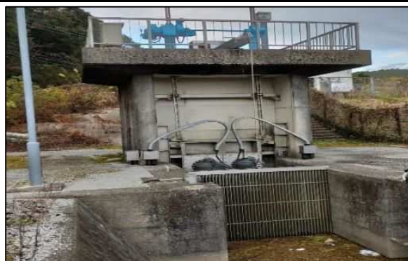
木立排水機場
