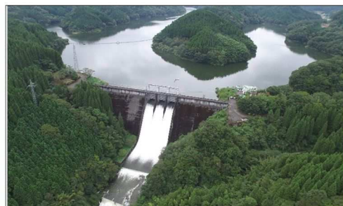
ダム（芹川ダム）
