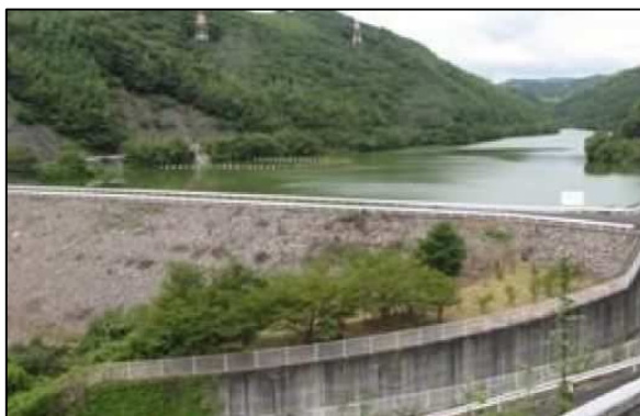
ロックフィルダム(鍋倉ダム)
