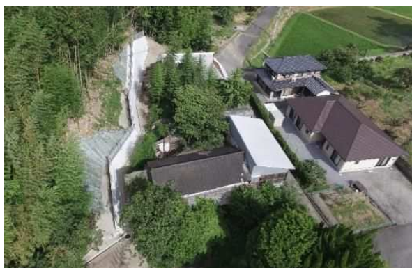
急傾斜地崩壊防止施設（日足地区）
