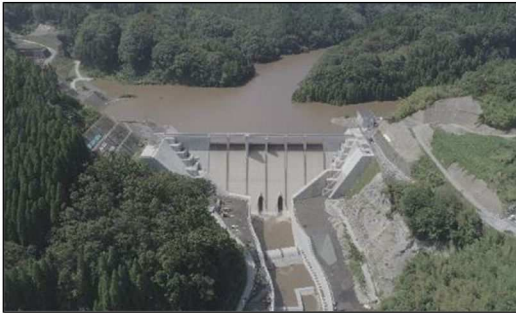
治水ダム(玉来ダム)
