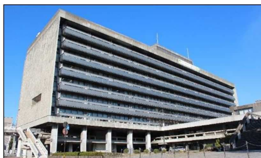
庁舎等(県庁舎本館)
