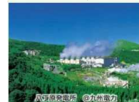
八丁原発電所 @九州電力
