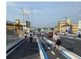
自転車通行空間の整備状況 (国道442号・大分市)
