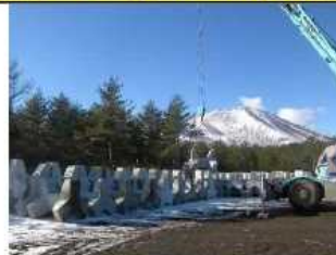
緊急対策用資材の製作・配備
