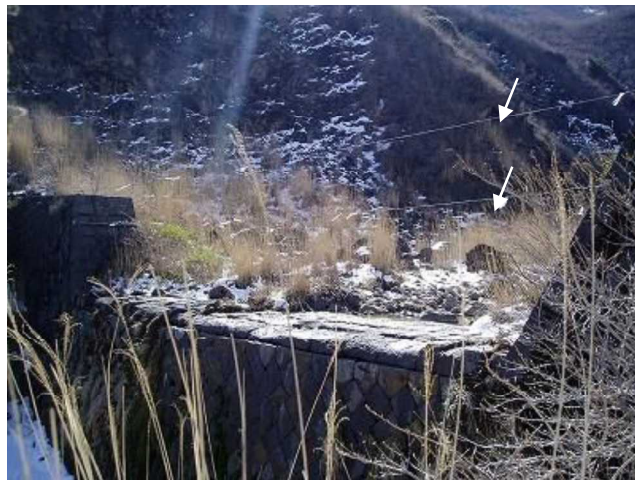
図 3.11 ワイヤセンサー設置状況（白水川第2号堰堤）
