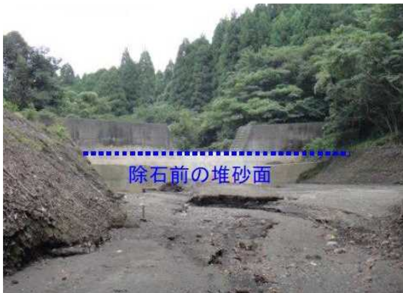
図 2.2 除石工の実施事例（除石後の堰堤堆砂地の状況；新燃岳における緊急対策事例）
