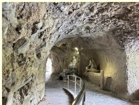
青の洞門内部
