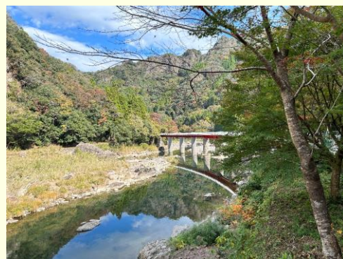
山国川第二橋梁
