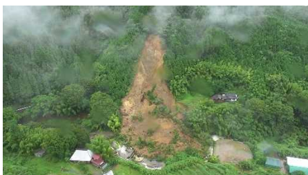
災害現場全容
