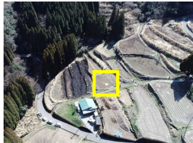
消防ドローンによるサイン旗の確認
