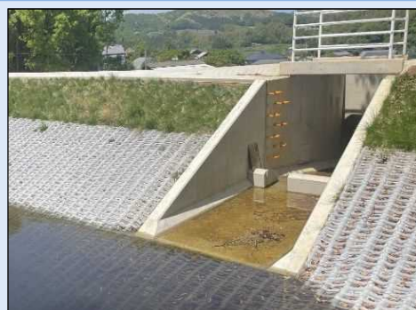
改修に併せ洪水吐スリットを設置(臼杵市)
