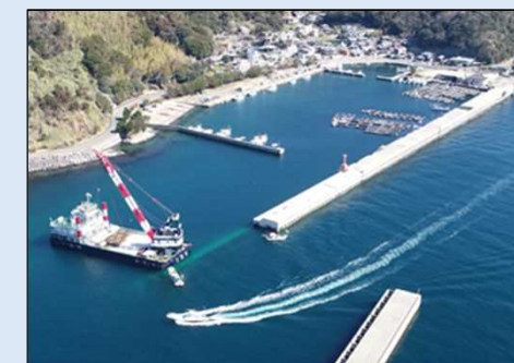
佐賀関漁港 防波堤耐震工事
