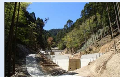
治山ダムの整備(中津市)
