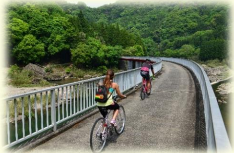
曾经的铁路大桥“第二山国川铁路桥”
